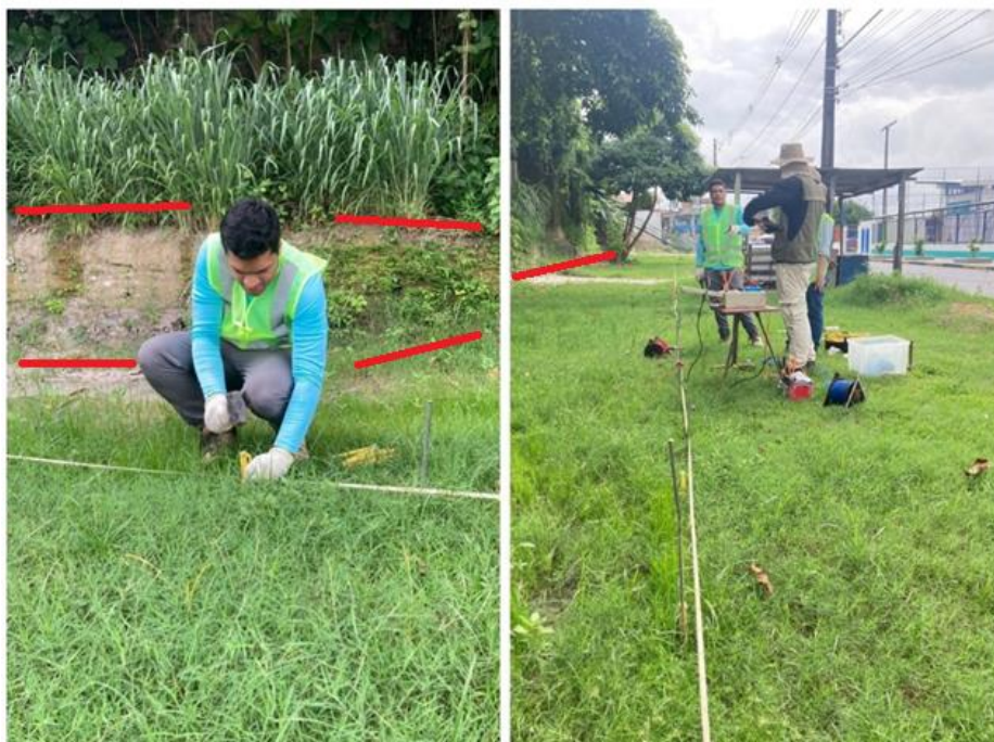
Figura 24 - Execução de Sondagem Elétrica Vertical em terreno próximo a quadra poliesportiva Campo da CEAM no Bairro São Francisco. As linhas vermelhas representam a contenção do talude
