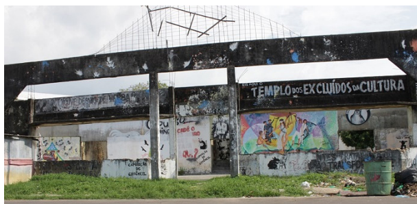
Figura 05– Frente do prédio da Casa da Cultura em 2016.
