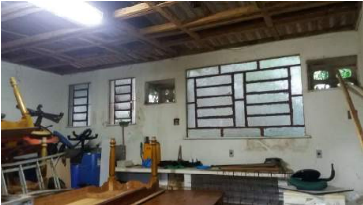
Figura 13: Depósito - Bloco B
