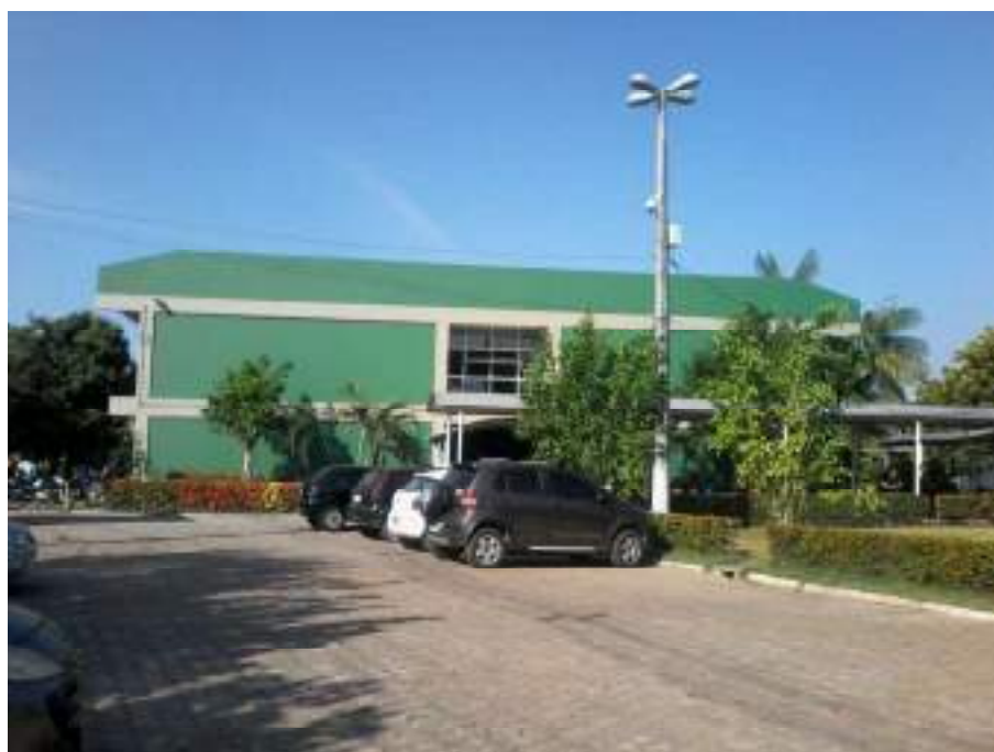
Figura 17: Poste de iluminação - Lâmpadas avariadas
