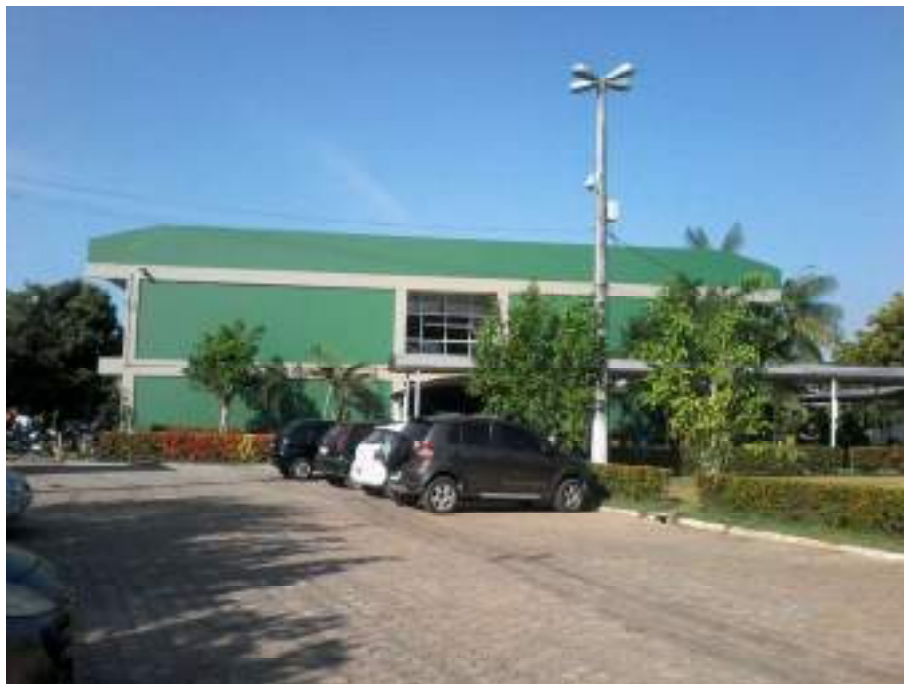
Figura 1: Vista lateral Bloco 1
