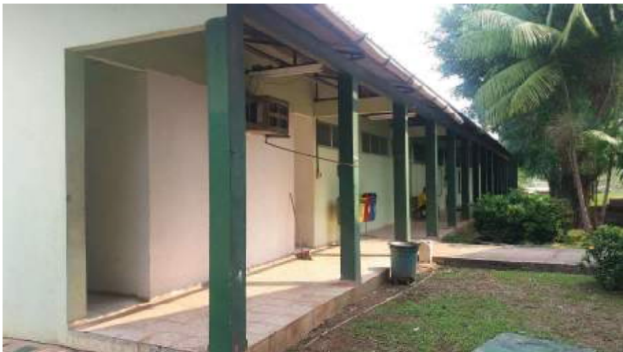
Figura 5: Vista frontal Bloco A
