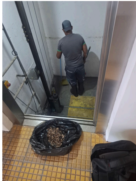
Figura 8 - Elevadores - Bloco Nelson Porto
