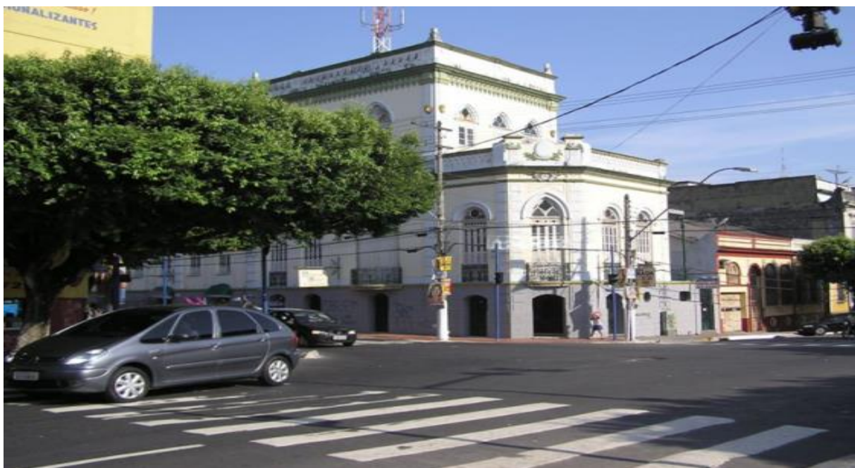
Figura 1: Primeiro Prédio da Faculdade de Engenharia, Centro de Manaus.
