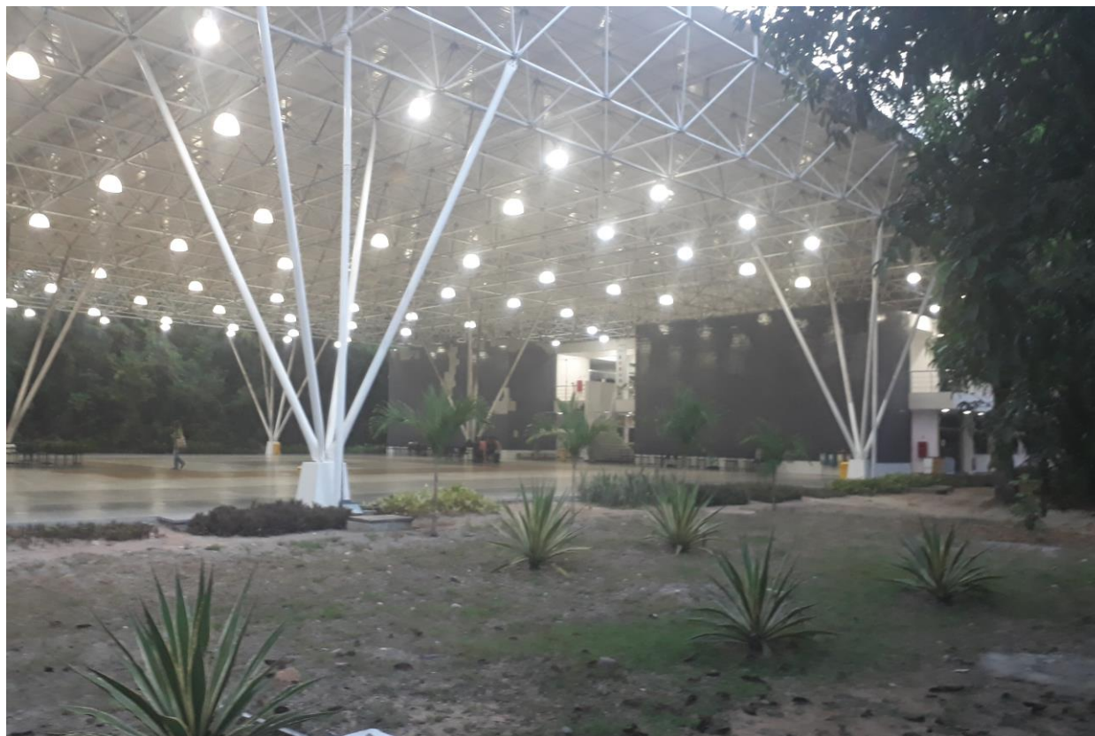
Fig. 01: CENTRO DE CONVIVÊNCIA – SETOR NORTE – CAMPUS UNIVERSITÁRIO DA UFAM
