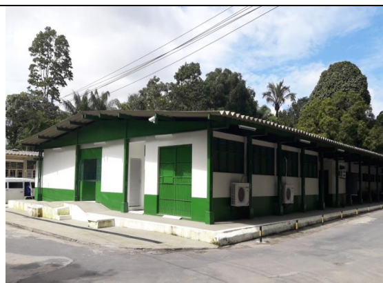
Restaurante do Bloco “R”, Setor Sul do Campus Universitário.
