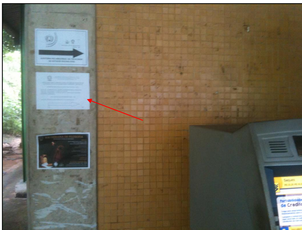
Figura 6 - Identificação das salas do concurso do ICHL e FES a partir dos caixas eletrônicos instalados no ICHL
