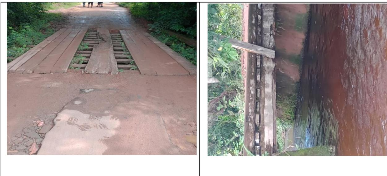
Fig. 02 e 03: Detalhes da ponte de acesso ao terreno e o igarapé. Ponte de madeira, com extensão de 4m, apresenta estrutura comprometida.
